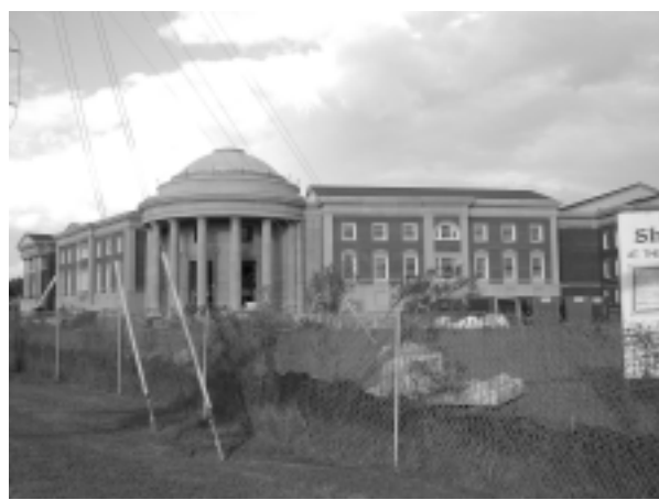
図 4 建設中の Shelby Hall (2003.11.4 撮影)
